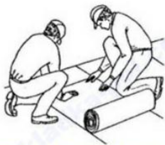
Укладка Напольных Покровтий
