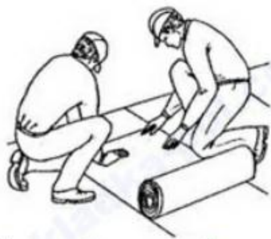
Укладка Напольных Покровтий
