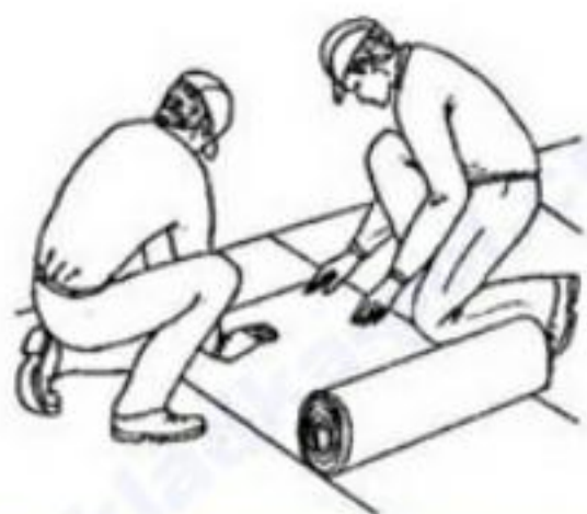
Укладка Напольных Покровтий
