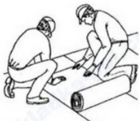
Укладка Напольных Покровтий
