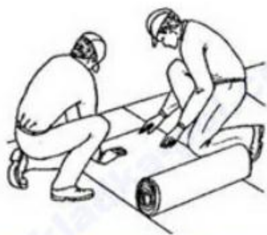
Укладка Напольных Покровтий
